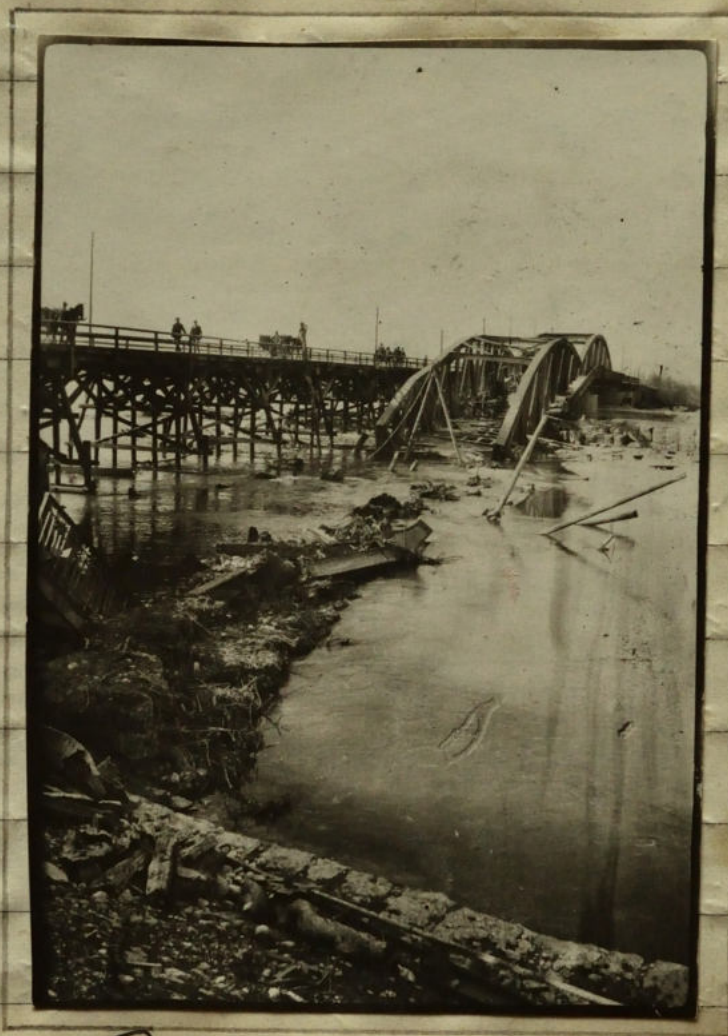
Ponte di Lagrado
