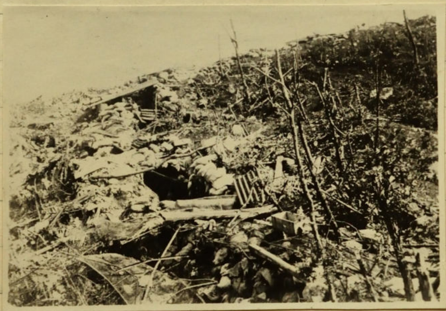
Baracche e trincee sul Carpo
